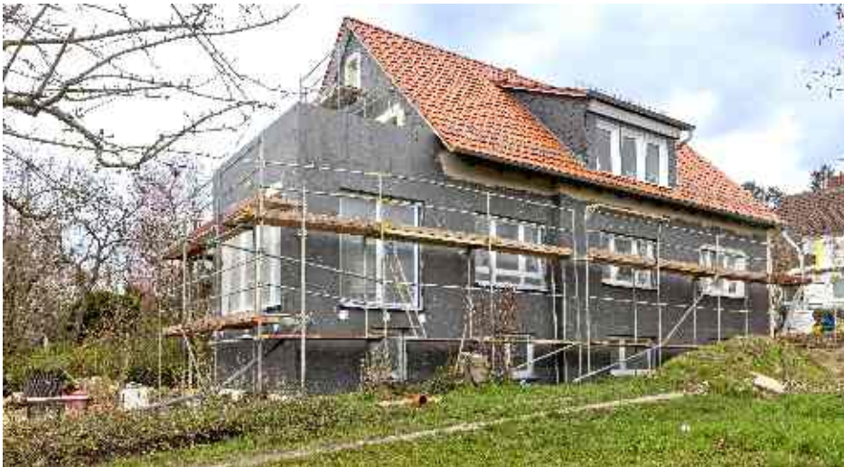
Kauf und Sanierung eines älteren Gebäudes können mitunter attraktiver sein als ein Neubau. Foto: DJD/Sto
