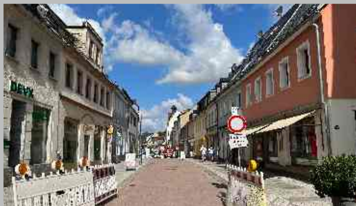
Blick in die Rochlitzer Straße von Mittweida während der Bauarbeiten. Foto: Peter Großer
