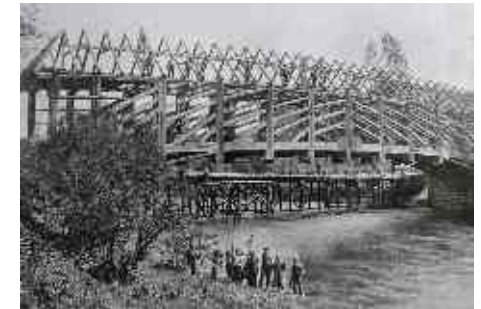
Diese tolle Holzkonstruktion der Mittweidaer Zschopaubrücke - hier beim Abbruch 1894 - gab den Ausschlag dafür, dass sich Bernd Jentsch auf die Spuren Napoleons in der Region begab. Foto: Sammlung Uwe Schönberner
