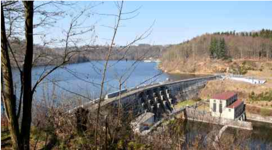
Staumauer der Talsperre Kriebstein mit Blick zur Seebühne und Hafen. Foto: Uwe Schönberner
