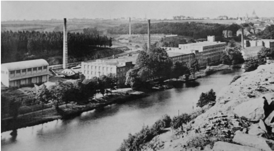
Ansicht des gewaltigen Areals der Baumwollspinnerei Mittweida vor etwa 90 Jahren. Ganz rechts am Bildrand: das fürs Jobcenter rekonstruierte Gebäude. Foto: Sammlung Uwe Schönberner
