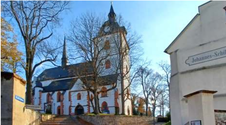
Der neu gepflasterte und gestaltete Haupteingang zur Stadtkirche. Foto: Uwe Schönberger
