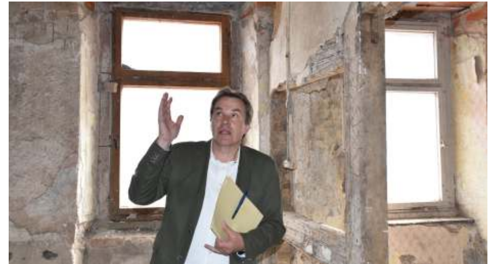
Mittweidas Oberbürgermeister Ralf Schreiber erläutert den maroden Zustand im Inneren des Gebäudes. Foto: Uwe Schönberner
