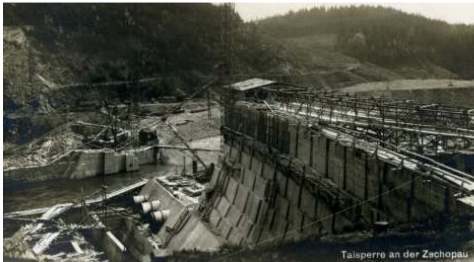
Talsperre an der Zschopau
