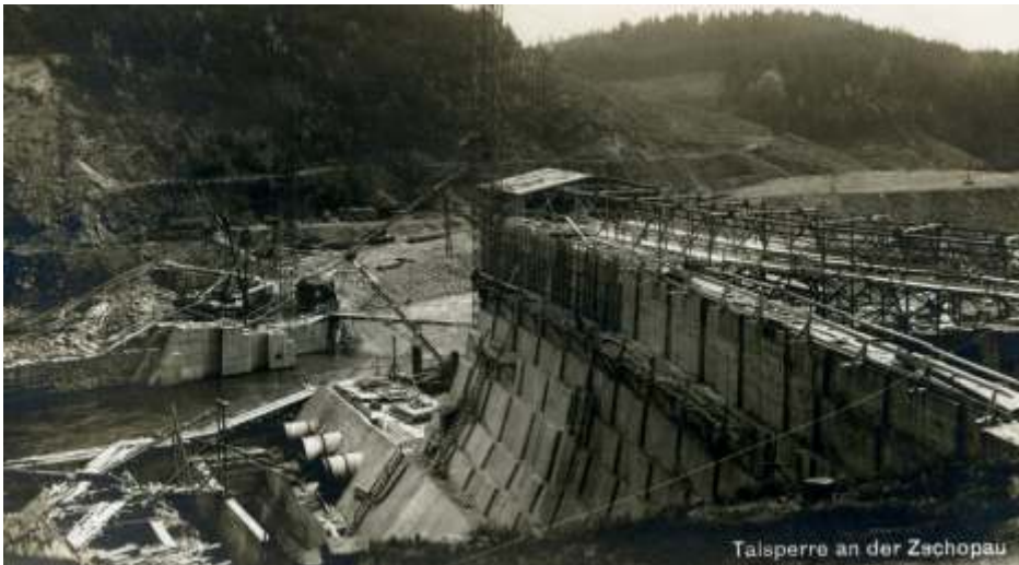
Talsperre an der Zschopau
